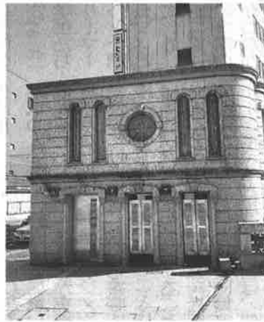
栃木名産の大谷石を全面に採用し景観になじんだ外観
