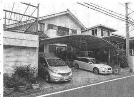
違和感を覚えるカーポートの広 さ。建ぺい率が過大に見える
