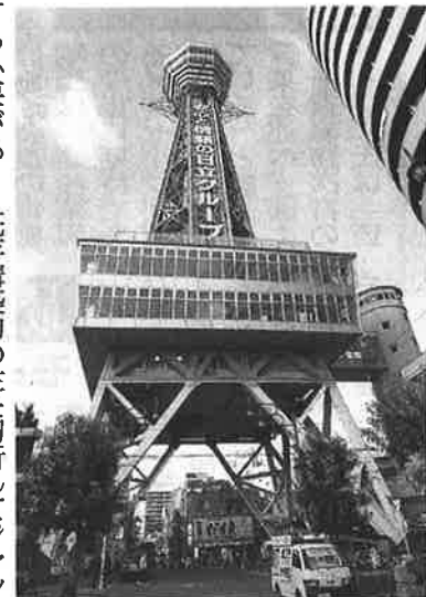
免震改修で大地震で倒れない塔になった大阪・通天閣
